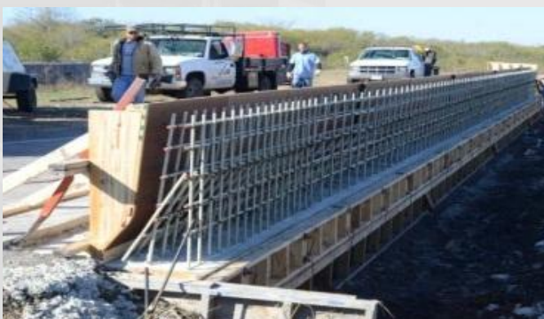
Glissière de sécurité en béton renforcée de fibres de verre
